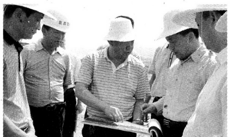
由陕西中煤建设分公司负责施工安康市滨江大道三期防护工程属安康市十二五重点工程。建设过程中,中煤公司在克服水文、气象影响的同时,加大施工力度,目前工程已经完成总工期的百分之五十。图为安康市市长方玮峰现场办公。 陈涛 唐登林 摄
