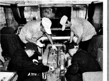
近日,安康供电段抽调业务过硬的轨道车司机和内燃钳工,对轨道车进行“联合会诊”,全面排查整治设备隐患,确保汛期行车安全。 王鹏 摄
