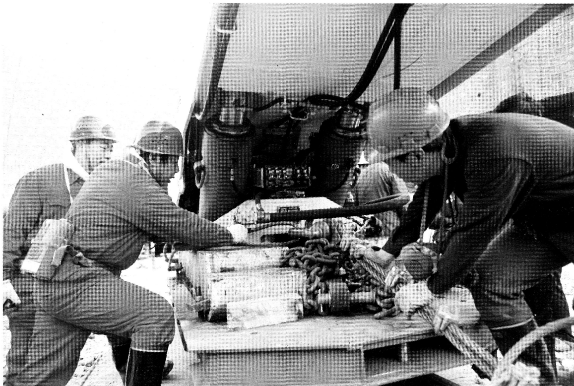
近日, 陕煤建司瑞能煤业第一架液压支架顺利运往井下, 标志着该矿彻底告别高档普采, 全面进入综采时代, 与此同时, 新运输系统的安全性和稳定性得到了进一步的考验。 图为公司督导组现场监督指导, 保证液压支架顺利入井。 张磊 摄
