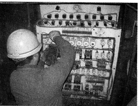
略钢矿业公司黑山沟分公司动力车间认真开展锅炉及供暖设备的年检维护保养工作,及时排除隐患缺陷,确保锅炉冬季供暖安全稳定运行。图为电工针对操作柜电器线路进行维护。唐旭波 摄
