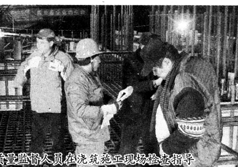
吉国质量监督人员在浇筑施工现场检查指导
