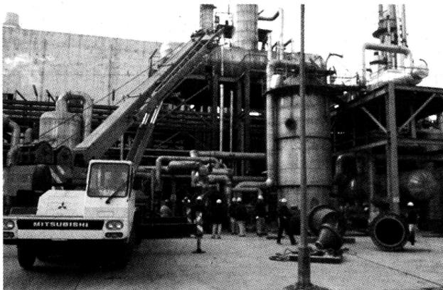
渭化公司双甲车间利用二期装置停车间隙,在检修部等相关部门配合下,进行了E2502换热器壳体更换工作。为确保更换工作的顺利开展,双甲
