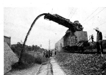
“1至7号防护员，现场施工完毕，请收好防护用品，撤离现场。”随着施工负责人解海军的一声命令，为期15天的经德工务段太中线路魏家楼至子洲区间线路大修清筛施工落下帷幕，也标志着该段对线路冻害采取的“冬病夏治”配方首战告捷。
