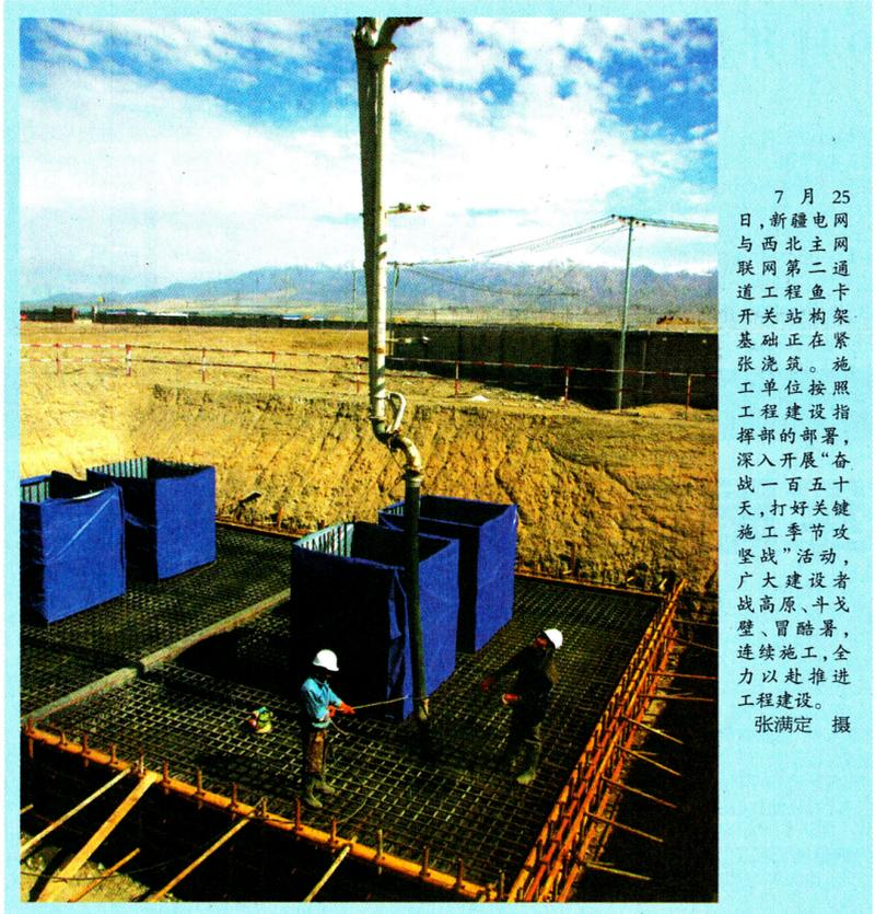
7月25日,新疆电网与西北主网联网第二通道工程鱼卡开关站构架基础正在紧张浇筑。施工单位按照工程建设指挥部的部署,深入开展“奋战一百五十天,打好关键施工季节攻坚战”活动,广大建设者战高原、斗戈壁、冒酷暑,连续施工,全力以赴推进工程建设。张满定 摄
