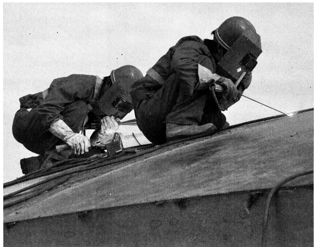
图为陕煤化集团的第一个出省项目——陕煤建司建丰公司煤化工项目装置区施工现
