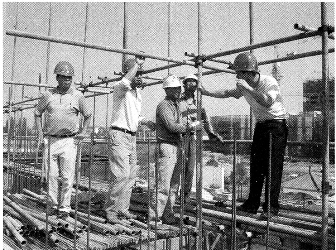
最近,陕西建工集团二公司深入全公司几十个工地进行安全拉网式大检查,开展以查“三违”隐患、查制度措施、查管理责任为主要内容的三查活动,以确保建筑工地的生产安全。图为第四分公司安全领导小组成员深入千阳工地检查外架搭设情况。徐宗凡 摄
