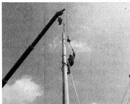
日前，中铁二十局集团电气化公司玉铁项目部围绕“营造良好干大氛围，按期建成玉铁线”的工期目标，深入开展了“比安全质量、比施工进度、比标准化管理”为主要内容的劳动竞赛活动，图为担负施工的黎湛线玉林站至铁山港支线131.46KM的电力贯通线第一杆高杆树立，拉开了施工干大高潮的序幕。 刘红刚 摄
