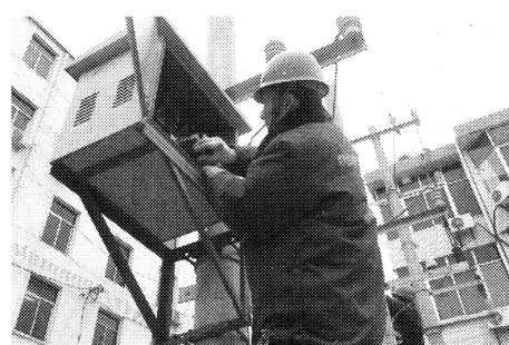
2013年以来,宜川县城关供水所为了保证城区人民冬季春节用电,组织全所15名职工进行岗位练兵,用真情、真本事服务宜川城区人民。 姚树林 摄
