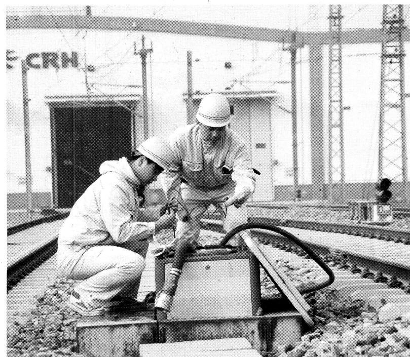
为给旅客提供快捷舒适的乘车环境,西安客车站段组织精兵强将,加大对动车组地面集污设备的检修力度,确保春运动车组集污时间快速及时。图为该段业务骨干正在对集污设备进行检修。 赵伯顺 摄
