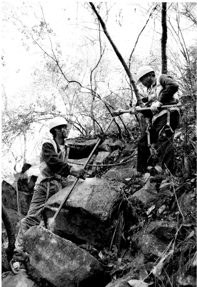
西安铁路局安康工务段在汛期到来之前发动全员力量,对管内襄渝、西康铁路所有山体活危石进行过筛式排查,发现隐患
