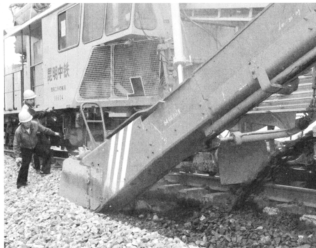
连日来,西安工务机械段紧盯施工关键环节,加大施工重点部位的卡控力度,不断提高施工质量,确保
