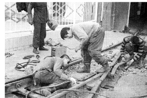
铜川陈家山煤矿运输区紧密围绕安全主题,开展安全隐患大排查活动,对煤罐笼、井口轨道进行了大检查。 毛博 邵红旗 摄
