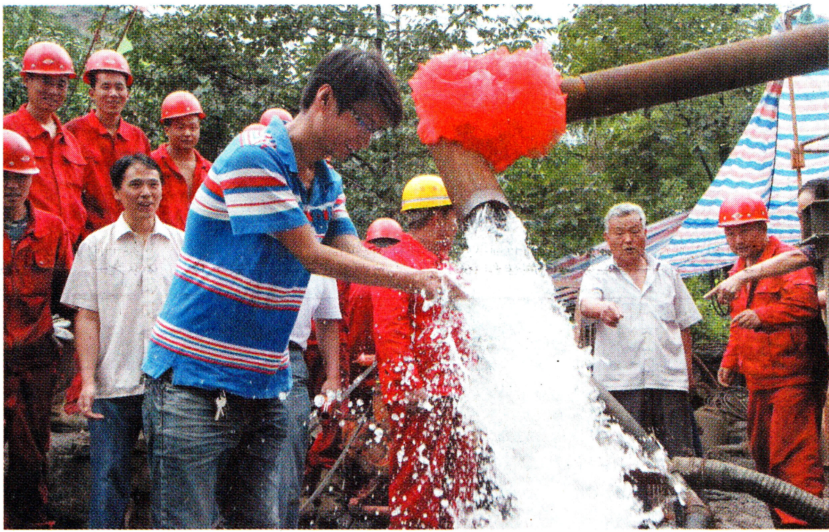
7月4日,投资2000余万元,备受韩城桑树坪矿区数万职工群众关注的惠民工程卫家河提水工程竣工。据了解,该井井深240.8米,
