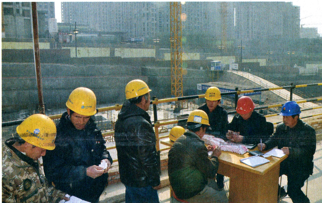
春节即将来临之际,镇巴县总工会联合县人社局、城乡建设局、公安局组成联合执法小组,开展农民工工资支付情况专项检查工作。
