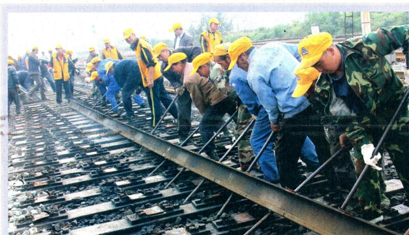
10月15日,西安工务段精心编排施工方案和施工计划,严格卡控现场安全和施工质量,全面打响陇海线第二阶段集中修。图为该段机械化修理车间在华山站更换道岔。李毅安 摄
