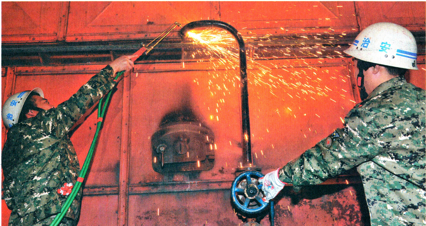
4月15日,拆改工人就地对西北大学桃园校区一台6蒸吨锅炉实施拆解改造,此举将减少450吨烟尘、24吨二氧化硫排放。
