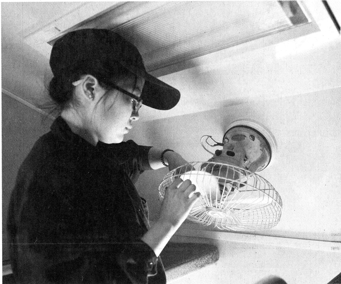
连日来,西安铁路局西安客车站积极组织开展客车空调、电扇等防暑设备检修工作,为夏日旅客出行营造安全舒适的乘车环境。图为该段职工正在安装调试电扇设备。 赵伯顺 摄
