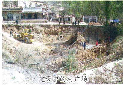
建设中的村广场
