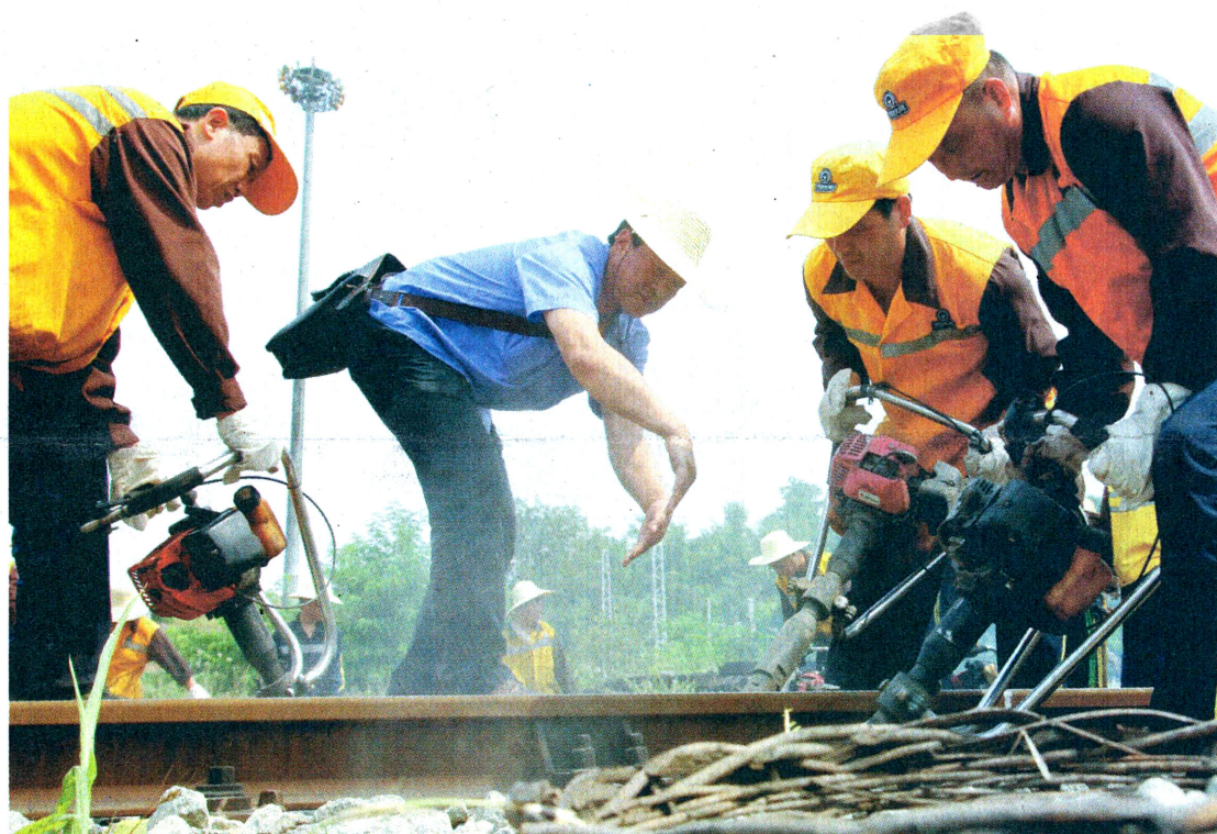
为确保7月1日管内调图顺利进行,西安铁路安康工务段组织15个机械化综合维修队伍,
