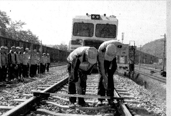
近日,针对雨季来临,黄陵矿业铁路运输公司组织开展了雨季“三防”演练活动。此次演练进一步检验了广大干部职工从发现险情,到现场应急处置等一整套流程的正确掌握,有力地提高了该公司应急抢险处置能力。 张红梅 摄
