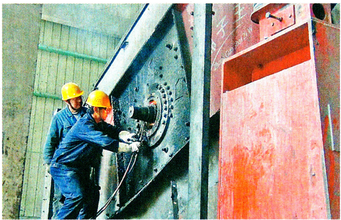
汉中嘉陵矿业公司黑山沟分公司维修车间把设备日常维护与计划检修有机结合,大力整治设备暴露的大小问题和潜在隐患,全力提
