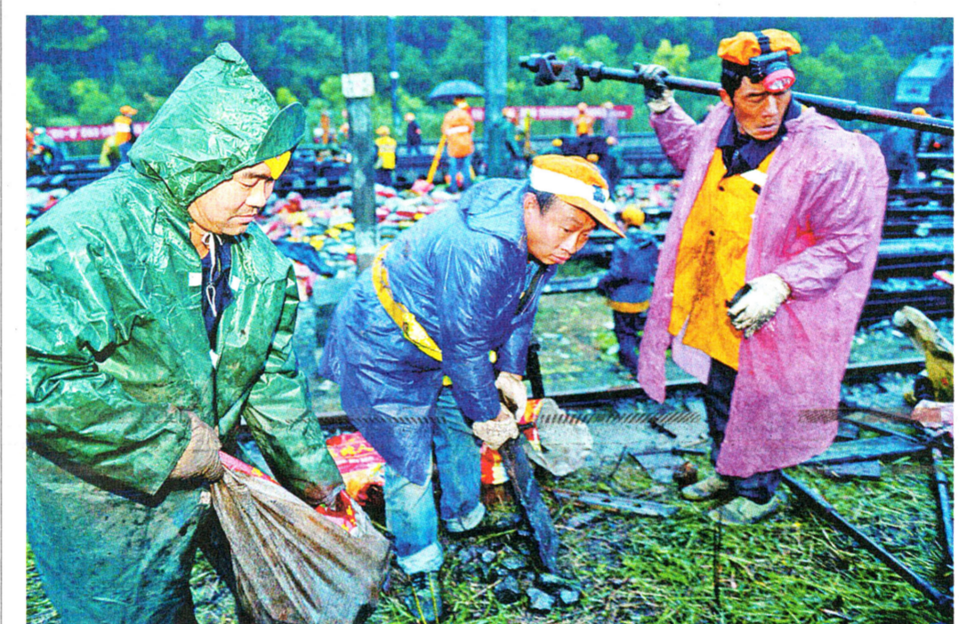
近期,西安铁路局集中力量对陇海线、阳安线进行更换道岔、线路清筛、机械化维修作业等,努力提高铁路线路设备质量,确保铁路运输生产安全。图为近日,汉中工务段在阳安线沙河坎车站冒雨进行更换道岔施工。 本报记者 郭玉军 摄
