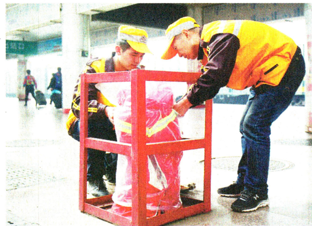
寒冬在即,为防止各种管路、阀门受冻发生脆裂、折断影响铁路运输生产的故障发生,西安建筑段提早组织人力物力对全段所有客车供水设备、站区消防设备进行“穿衣盖被”防寒保养。
