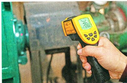
西安市热力总公司员工每隔两小时就对水泵进行一次测温,确保锅炉安全运转。本报记者 鲜康 摄
