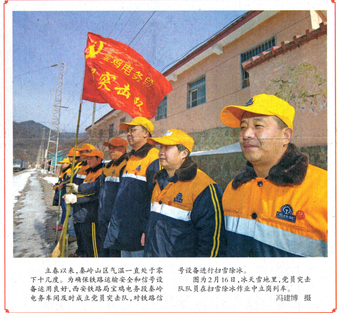
立春以来,秦岭山区气温一直处于零下几度。为确保铁路运输安全和信号设备运用良好,西安铁路局宝鸡电务段秦岭电务车间及时成立党员突击队,对铁路信号设备进行扫雪除冰。
