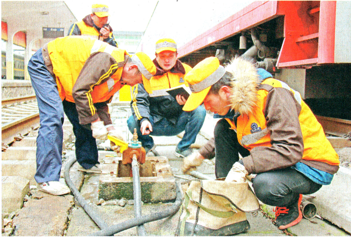
近日,西安铁路局西安建筑段针对管内点多线长、普铁、高铁设备交叉,且多、杂的特点,开展春季设备大检查大整治活动,全方位、立体式查找设备安全问题,不留死角整治隐患,夯实设备
