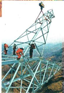
1月4日，在商南县试马镇百家岗村，昌吉-古泉±1100千伏特高压直流输电工程跨越秦岭首基铁塔组立顺利完成。该基铁塔高约100米，所用塔材重达155吨。
