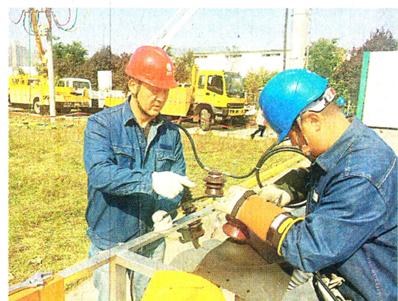
为进一步保障西安电网安全稳定运行,全方位提升抢修能力,昨日,国网西安供电公司带电作业室组织职工在实训基地进行技能强化培训。图为培训职工快速带电绑扎瓷瓶。 本报记者 钟洁 摄
