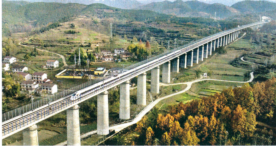
参加模拟运行的 55251 次 CRH3A 型动车组列车通过秦岭任家山高架桥(11 月 22 日摄)
