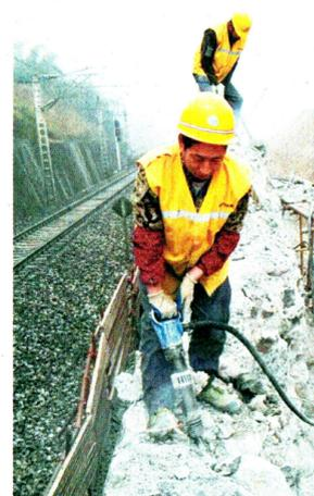
中铁十局集团承建的新建渝怀铁路涪陵至秀山段(涪秀二线)紧邻营业线施工。此地段地势险要,营业车流密度大,安全风险高。涪秀二线铁路项目采取有效防护措施,人工拆除既有隔离墙,确保营业线安全运营。图为近日,该段作业人员在施工前拆除既有隔离墙。斯琴摄
