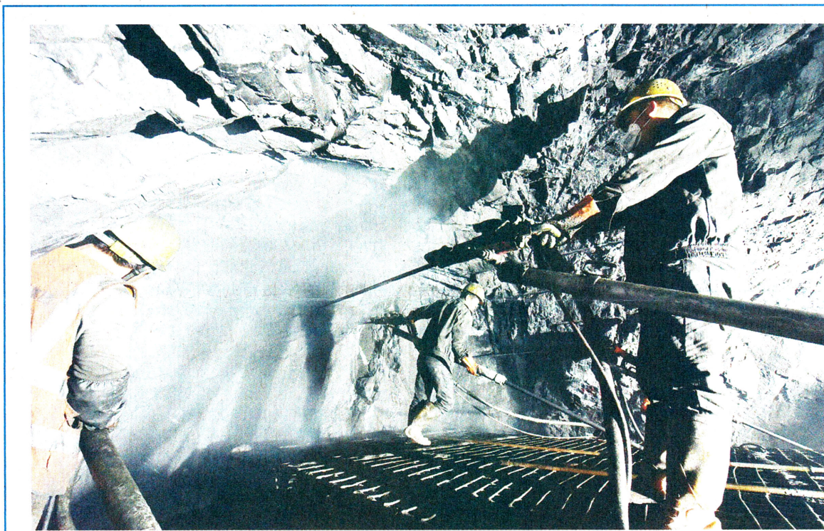
5 月 1 日,在位于汉中市佛坪县引汉济渭岭南黄三段三、四号隧洞工作面,中铁十七局二公司的建设者一边熟练操作湿喷机喷浆稳定围岩,一边手握钻枪打眼爆破。目前,三河口水利枢纽大坝已浇筑到 19 米高,秦岭输水隧洞完成开挖支护 70.7 公里,占到总长度的 71.9%。 袁景智 摄
