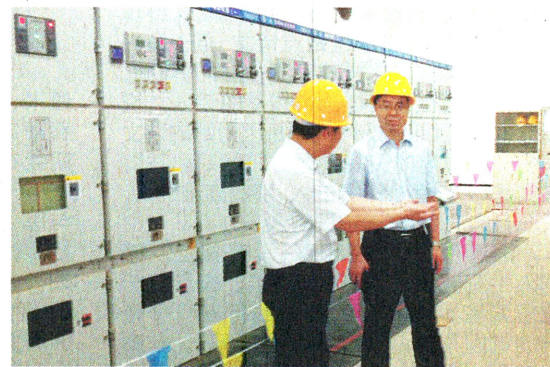
近日,中铁二十局集团电气化公司西安站改项目部及时制定多项措施,筑牢安全生产防护墙,为安全生产“拧紧安全阀上紧弦”。图为项目领导现场检查安全措施落实情况。 □通讯员 刘红刚 摄
