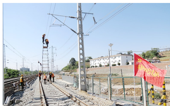
连日来,中国铁路西安局集团有限公司安康供电段充分发挥党员先锋模范作用,确保运输安全持续稳定。图为党员职工在大岭铺至安康东直通线施工现场作业。 段增旗 摄
