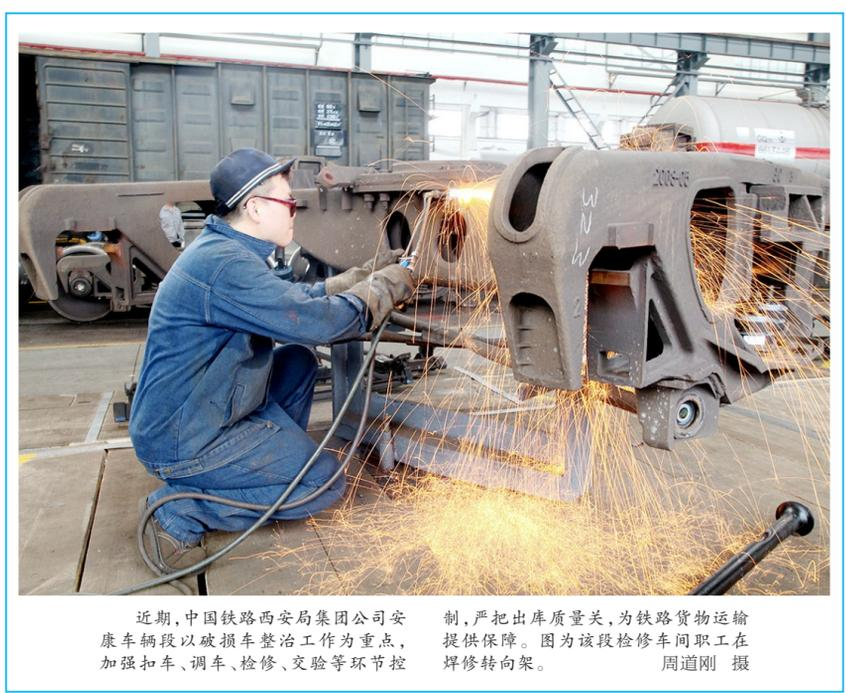
近期,中国铁路西安局集团公司安康车辆段以破损车整治工作为重点,加强扣车、调车、检修、交验等环节控制,严把出库质量关,为铁路货物运输提供保障。图为该段检修车间职工在焊修转向架。 周道刚 摄
