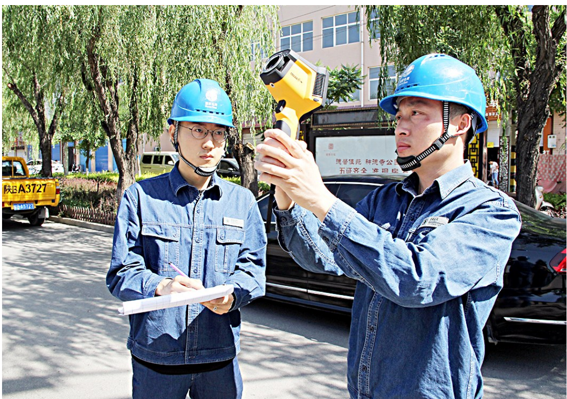
6月5日,为确保铜川市各区县高考考点的用电无忧,铜川供电公司保电工作人员再次对涉及10千伏线路、开关、变压器台区接点以及考点自备用设备进行巡视、测温、指导消缺,真正保证全市各考场用电万无一失。图为耀州供电公司保电人员现场检查用电设备。王同利 王深 摄
