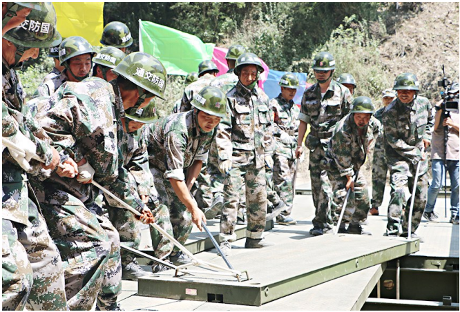
6月7日,由省公路局主持、汉中公路局具体实施的全省国省道干线公路应急抢险保通演练在316国道留坝武关河应急抢险工程现场举行。
