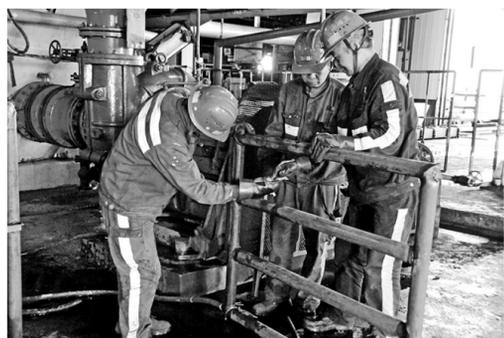
近日,建设洗选煤运营公司洗煤厂项目部对洗煤车间内的暖气系统进行更换,制作加工暖气片70余片,安装工作正在火热进行中。图为洗煤车间工人对加工好的暖气片进行加水打压,查找渗水点。 小宁 摄
