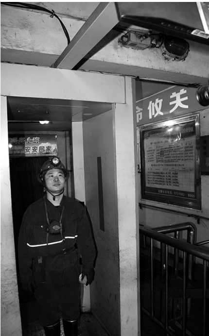
近日,澄合董东煤业公司通过在副立井口设立出入井人员“人脸识别考勤系统”,实现对出入井人员信息采集、数据统计和信息查询过程的自动化,提高了安全生产效率。同时,保证井下一旦发生灾害时,可提供有效的救援预案,使入井人员在最短的时间内得到救护。
