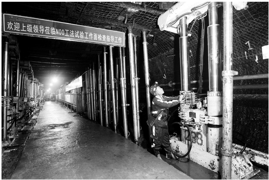
近日,陕北矿业柠条塔公司首采试验的“N00工法”工作面与回撤道顺利贯通,标志着该公司实施的“无煤柱自成巷N00工法
