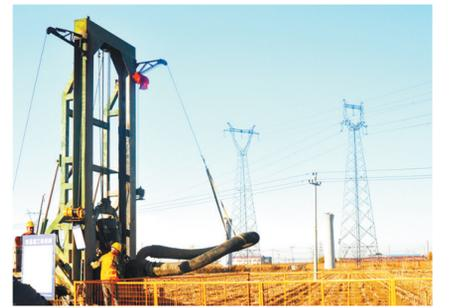
近日,在位于河北省唐山市高新区的京唐津泰上行联络线特大桥工地,中铁电气化局铁路工程公司的工人正在进行桥梁桩基施工。伴随着钻机的轰鸣声,第一根钻孔桩顺利开钻,标志着该司承建的京唐铁路引入唐山枢纽站前工程正式动工兴建。
