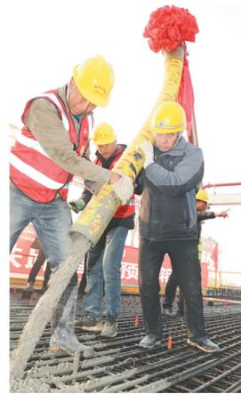
12月12日,益长(常德—益阳—长沙)铁路全线首榀箱梁预制在中铁十二局集团汉寿制梁场箱梁开始浇筑,标志着梁场施工已进入全面施工建设阶段。该制梁场率先在全线应用了智慧梁场管理平台,包括智能化箱梁模板、智慧管理平台、智能运输车、制梁张拉工艺及智能压浆系统,实现了绿色文明高效施工。 □丁明明 靳林柱 国占摄
