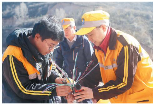
←进入12月份以后,西铁工程公司将剩余经营任务细化到日,全力确保施工安全有序和年度生产经营任务完成。图为在宝成线油房沟施工现场,该公司职工正在加班加点进行52芯电缆接续作业。 □田家卫 摄
