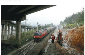
近日,中铁二十局用两周时间顺利将承建的渝怀铁 路涪秀二线K242~K244段新建路基的既有公路大桥两 根桩基拿下,该桥墩设计下部结构为桩接柱桥墩,上部 设计结构为横跨既有铁路30m箱梁,既有桩基设计桩长 13m,路基开挖高度均为5.4m段路基。 梁丽萍 摄
