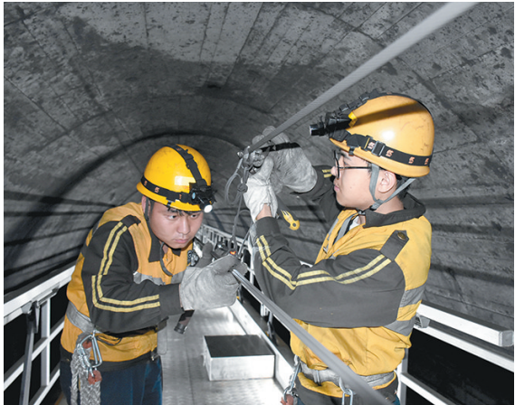
入夏以来,中国铁路西安局集团有限公司安康供电段积极开展供电设备隐患专项整治,强化设备安全风险卡控,及时消除安全隐患,确保供电安全稳定。图为该段维修车间职工正在襄渝线新五块一号隧道内检修吊弦。段增旗 摄
