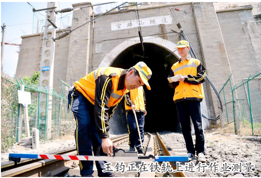
王钧正在铁轨上进行作业测量。
