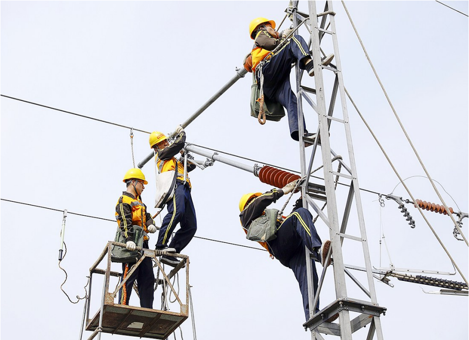
近日,中国铁路西安局集团有限公司西安供电段积极搭建人才成长平台,举办了青工职业技能竞赛,以
