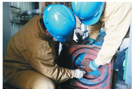
近日，国家能源集团国华锦界电厂完成了1、2机组喷淋水泵基础改造工作，可有效排除设备再被冻裂的可能，确保喷淋清洗设备平稳过冬。
